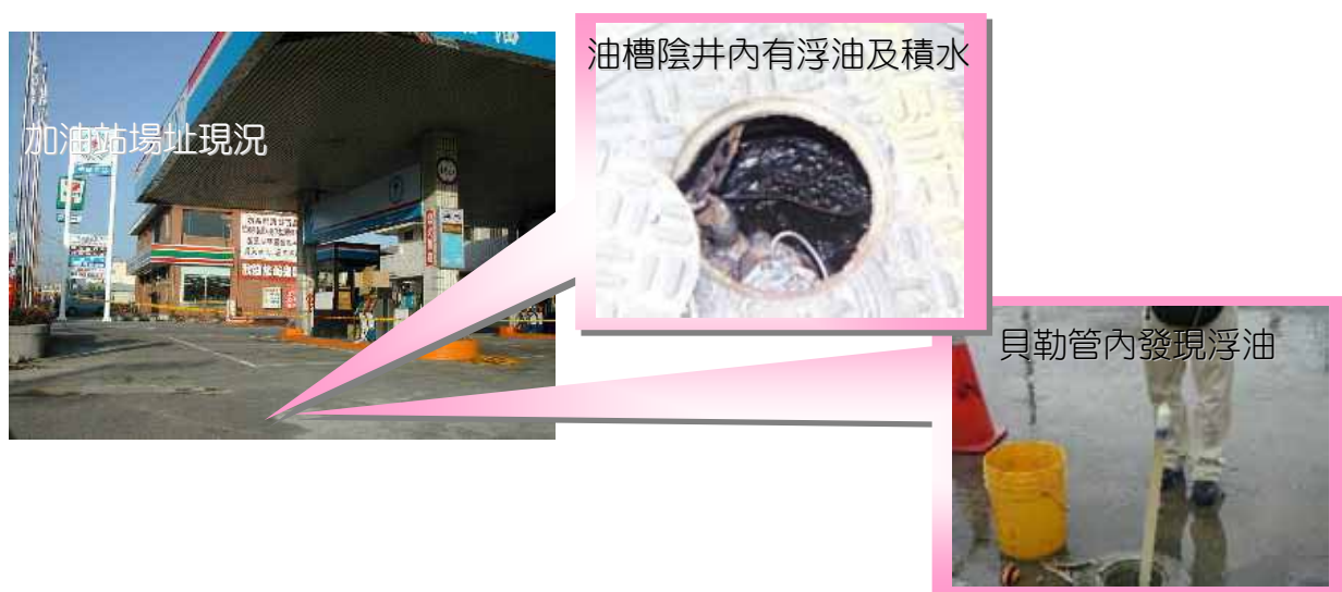
照片 6- 1 加油站污染情形
