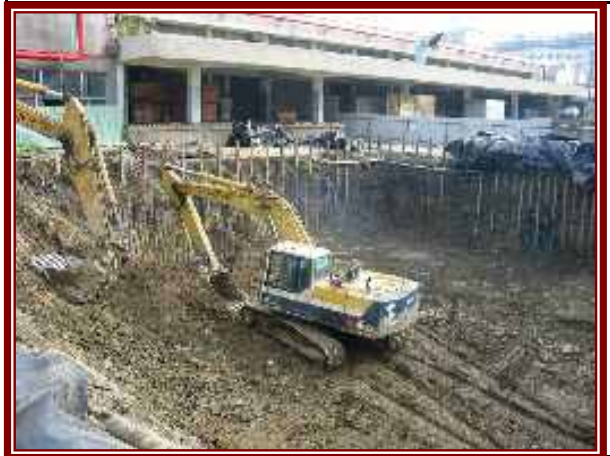
檔土與開挖工程
