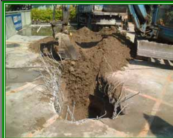
油槽區局部開挖
