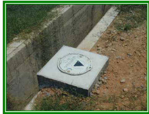
照片 4-2 隱藏式地下水監測井
