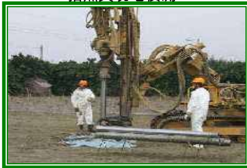
運用鑽孔方式調查採樣
