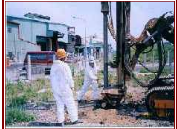
地下水監測井施作
