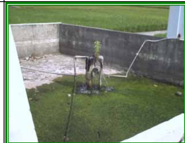
地下水抽除處理
