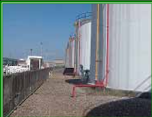
石化儲槽槽底、周邊
