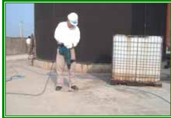
3.RC/PC破孔
